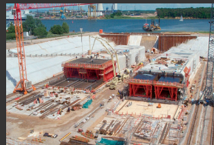
Einschwimm- und Absenktunnel Warnowquerung Rostock ■ Objektplanung Ingenieurbauwerke, Tragwerksplanung, Technische Ausstattung, Geotechnische Beratung
