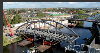
A 113, Berlin - Stabbogenbrücke Teltowkanal
