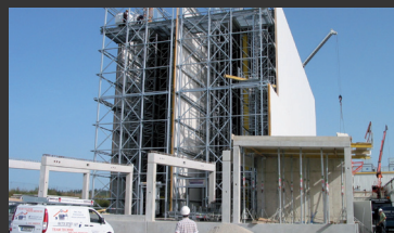
Hochregallager Alpenhain ■ Statisch-konstruktive Prüfung
