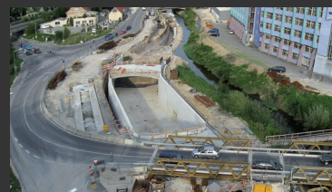
Straßentunnel Schwäbisch Gmünd ■ Objektplanung Ingenieurbauwerke, Tragwerksplanung, Technische Ausstattung, Bauüberwachung und Bauoberleitung, Sicherheitsbeauftragter nach RABT
