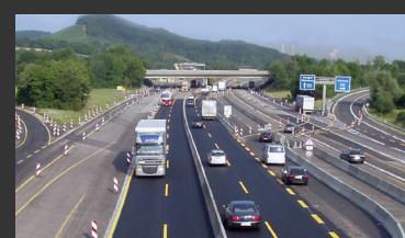
A 6 Autobahnkreuz Weinsberg ■ Örtliche Bauüberwachung
