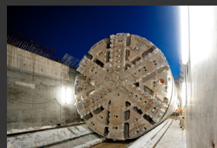
Finnetunnel ■ Bauoberleitung, Örtliche Bauüberwachung
